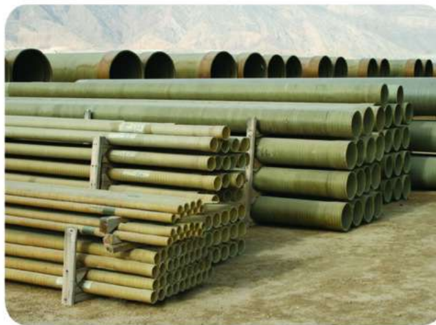
شکل (۵) - انباشت صحیح لوله ها در کارگاه
