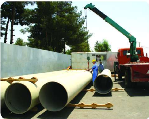
شکل (۲) نحوه تخلیه لوله در سایت
