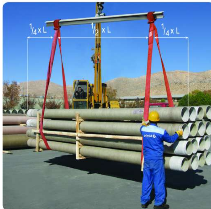
شکل (۳)- بلند کردن لوله های گروهی (دسته شده)
