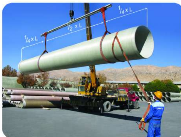
شکل (۴) - بلند کردن لوله با دو نقطه اتکا
