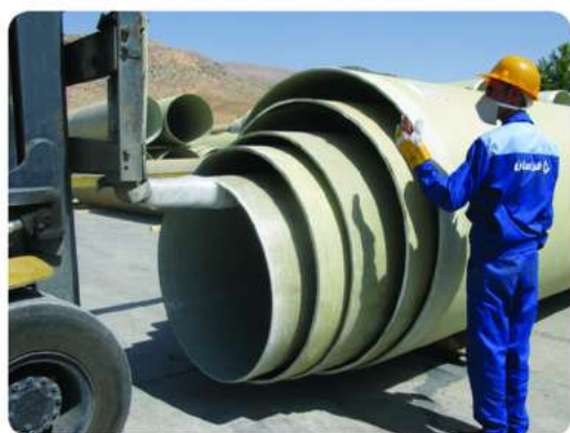
شکل ۸ - در آوردن لوله ها از داخل یکدیگر توسط بالابر لیفتراک (فورک لیفت)
