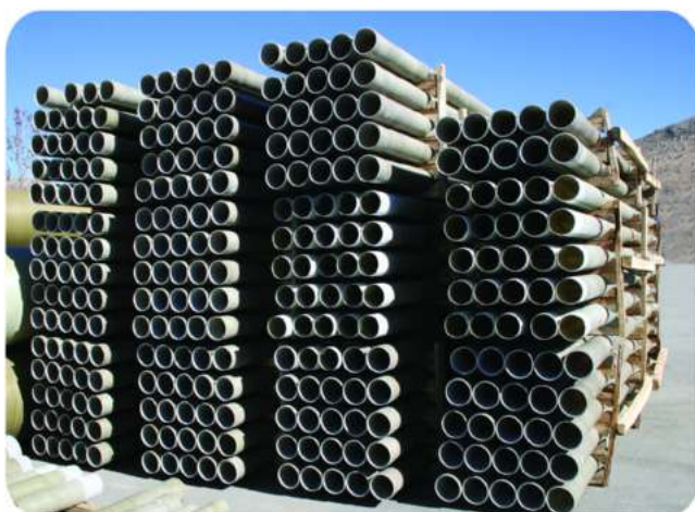
شکل (۵) - انباشت صحیح لوله ها در کارگاه
