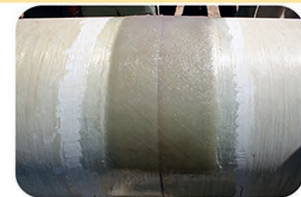
لکانی که وینی (Hand Lay up, Butt-Wrap)
