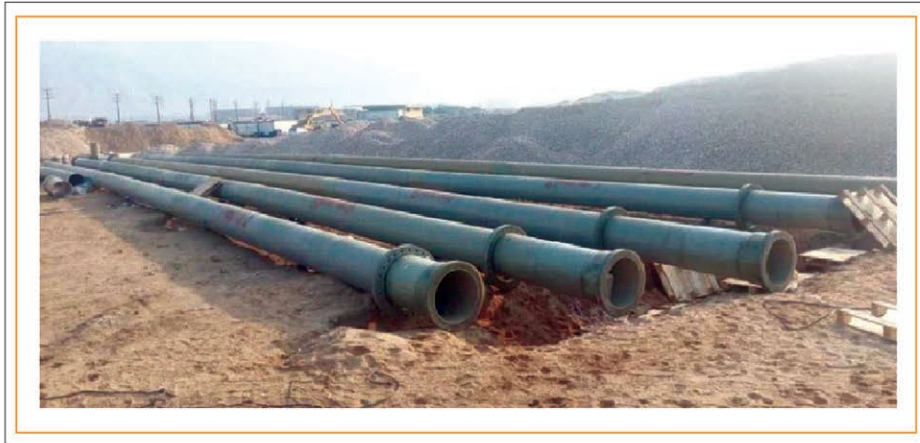
شکل شماره ۱۵ - اسپولهای ساخته شده در ساحل
