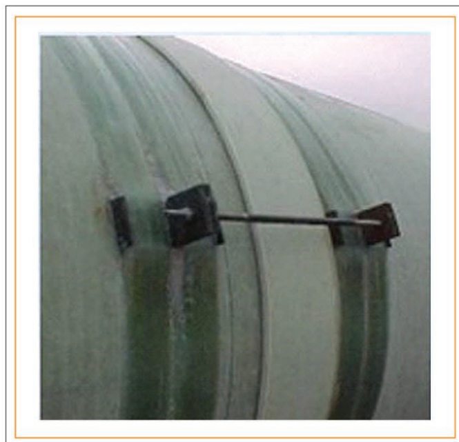
شکل شماره ۷ - کوپلینگ با لاگ (Lug) های مهاری دریایی
