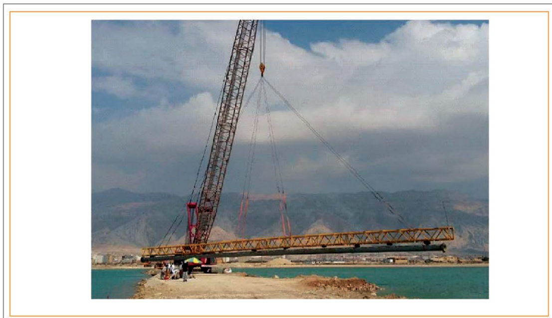
شکل شماره ۱۴ - انتقال اسپول به داخل ترانشه
