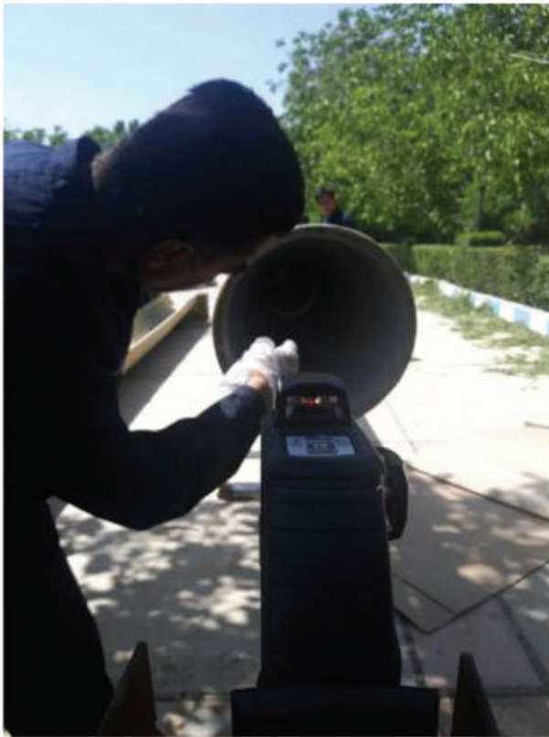
استفاده از لیزر و چسب فراتک برای تراز و اتصال قطعات
