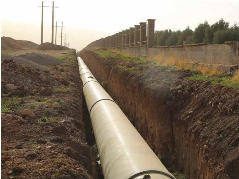
۱۱ - انحراف زاویه ای در محل اتصال
