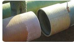
کوپلینگ چسبی (Adhesive Bond Coupling)
