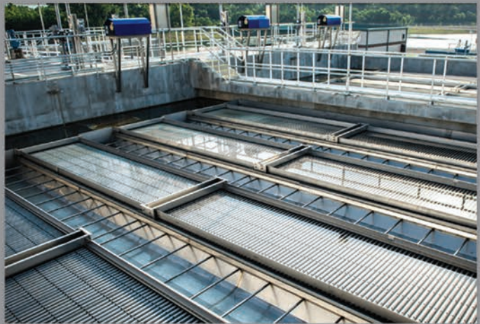
نمایی از فرایند تصفیه آب شرب توسط صفحات تصفیه کننده لاملا
