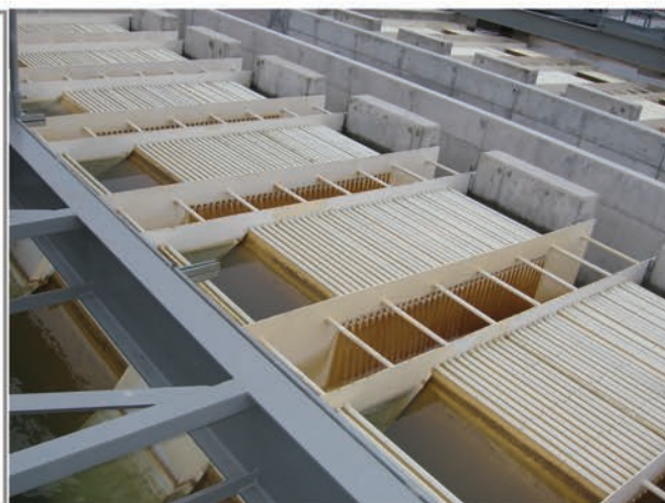
صفحات لاملا نصب شده در حوضچه
