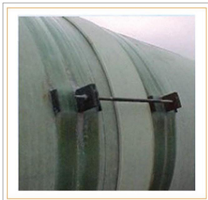
Рисунок 7 - Подводная муфта с поддерживающими зажимами
