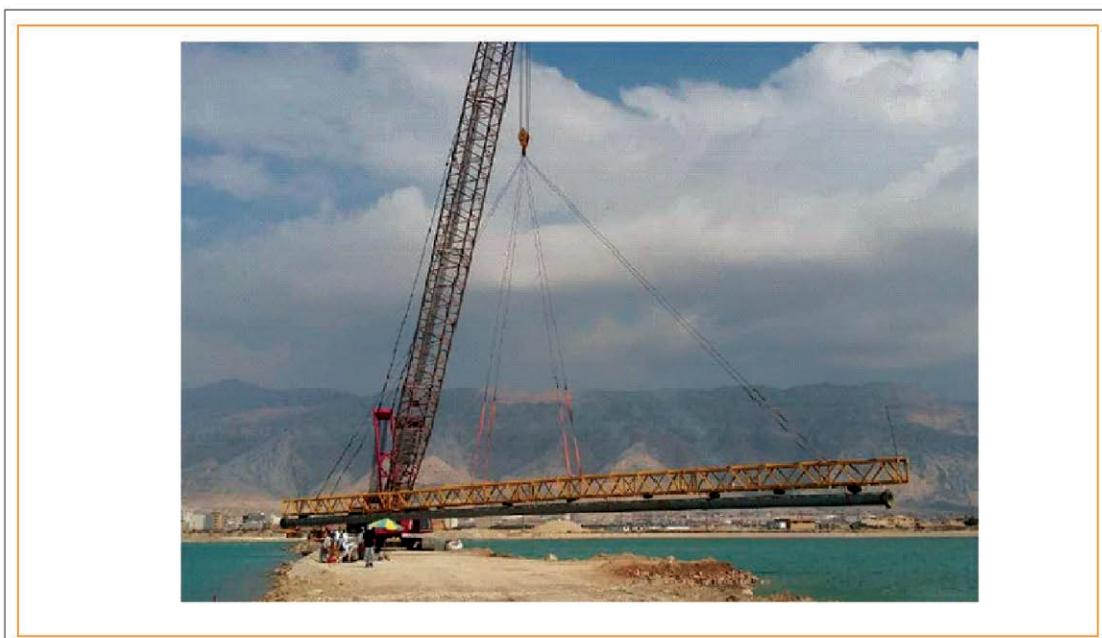
Рисунок 14 - Перевозка трубных секций в траншею
